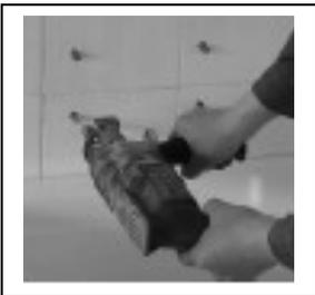
Bringen Sie die Befestigungsplatte an der Wand an (ca. 11cm über der Badewannenkante mit einem Ende der Platte in der Nähe des Beginns der Badewannenkrümmung). Markieren Sie mit Hilfe der Befestigungsplatte sechs Bohrlöcher an der Wand. Halten Sie die Platte dabei horizontal.
